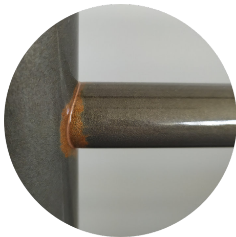
Detail spoje nátrubku a sběrnice stopy po pájení
